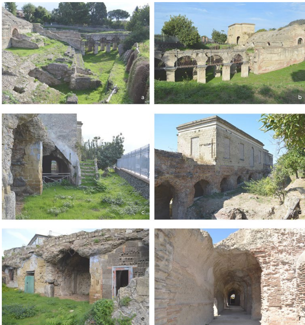
5: Mariangela Terracciano, Stadio di Antonio Pio, 2022. Viste del complesso oggi. a: vista della cavea e dell'ingresso trionfale alla pista; b: vista degli archi, della cavea e della masseria; c: vista della scala di accesso agli ambienti della masseria; d: vista del prospetto posteriore della masseria; e: vista degli ambienti della cavea adibiti a servizio della masseria; f: vista dell'ambulacro.
