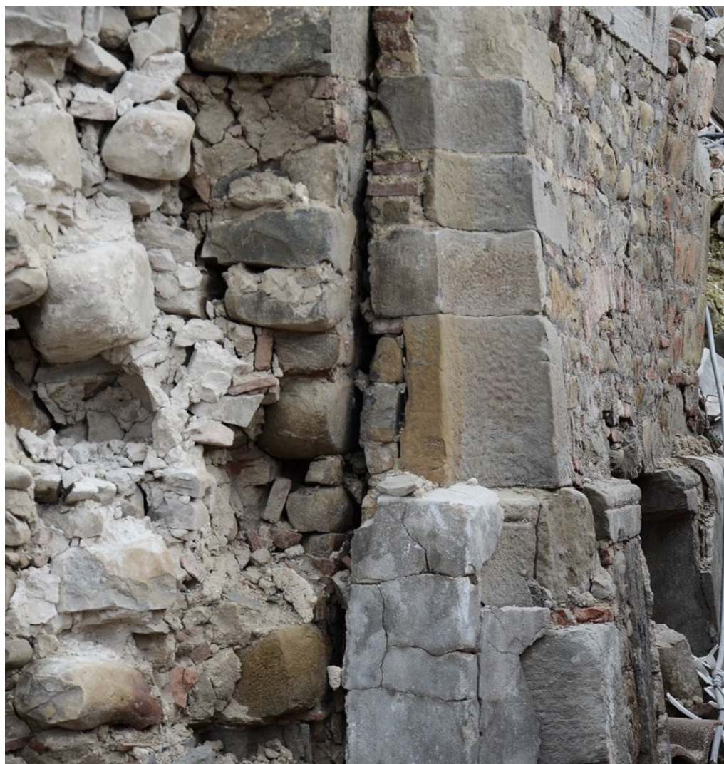
5: Amatrice, dettaglio della stratificazione muraria su via Roma, 2017 [Foto dell'autore].
