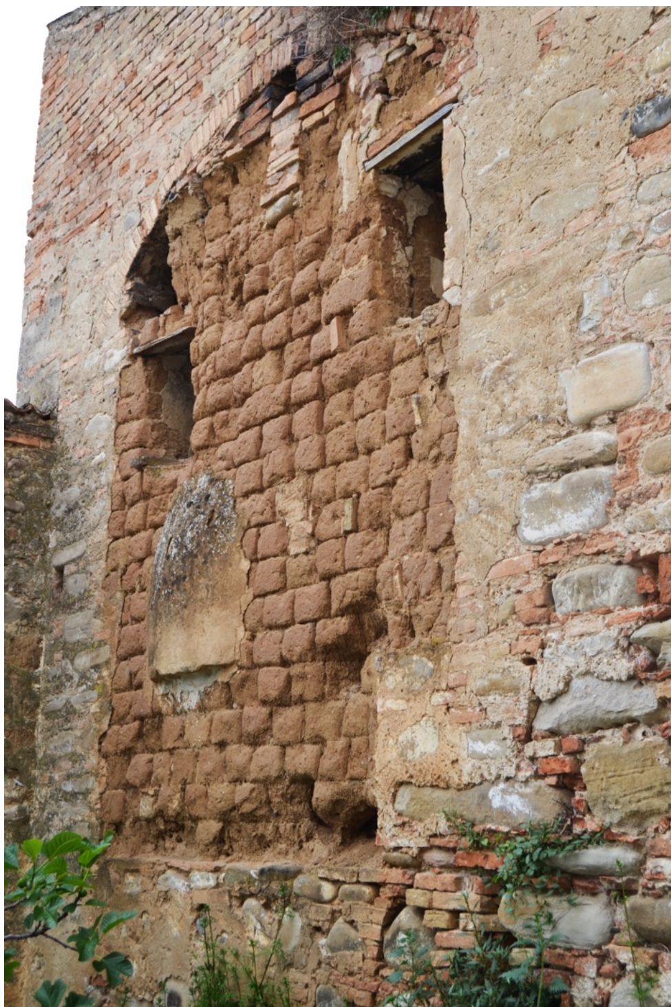
2: Aliano, Palazzo Corrente, muratura est [fotografia di R. Leone].
