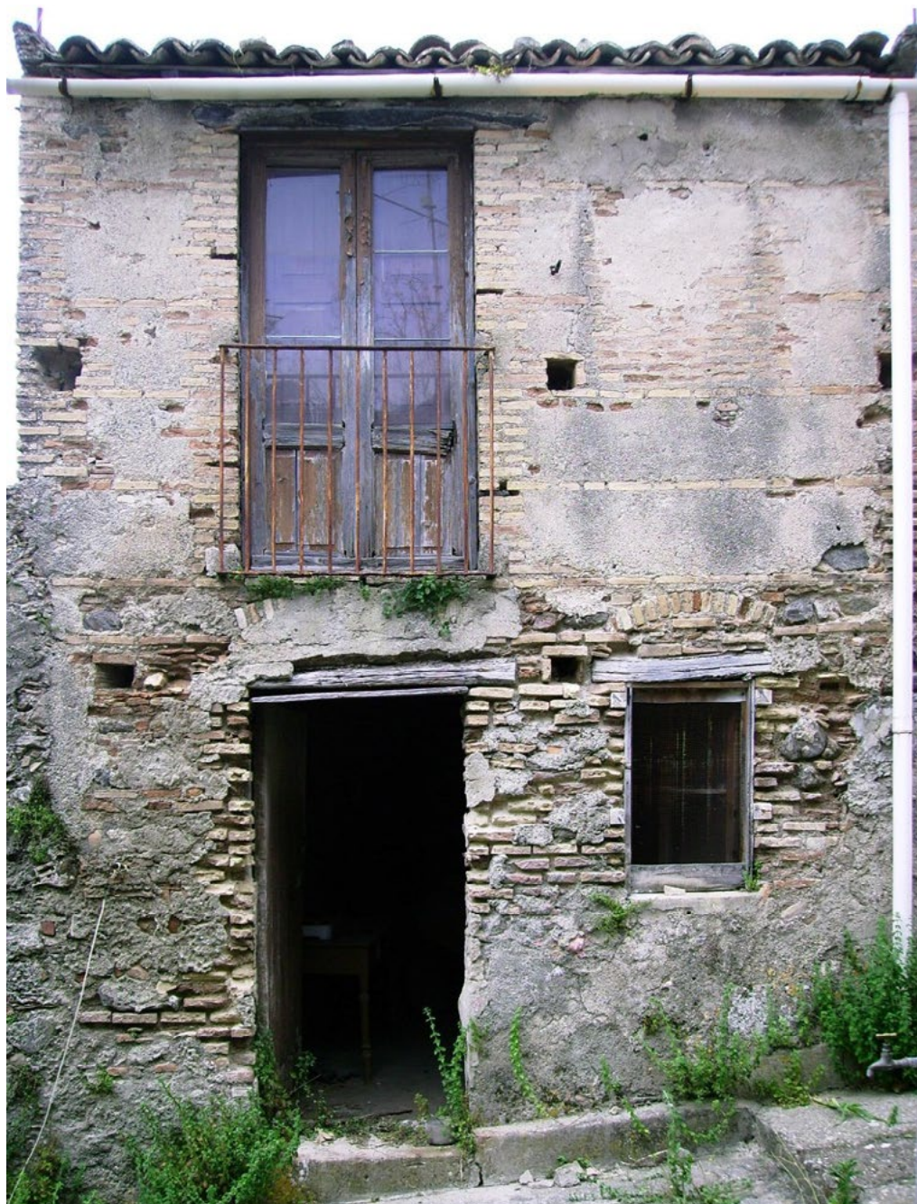
5: Particolare delle murature di una cellula edilizia del centro storico in cui si notano le fasi di crescita dell'originario manufatto, evidenziate dalle diverse tessiture murarie.
