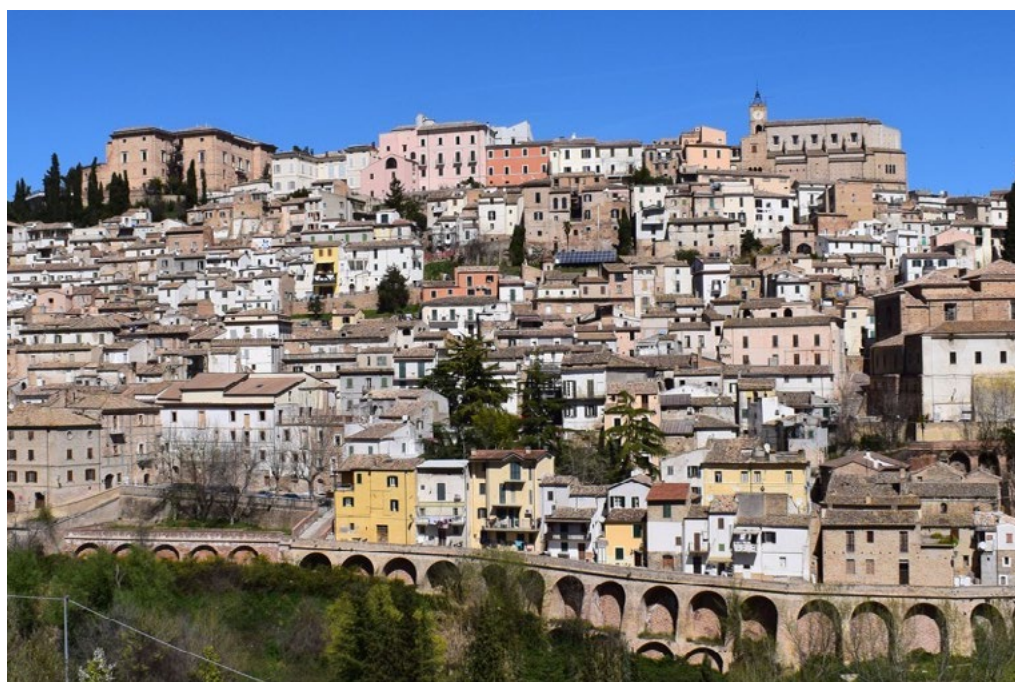
2: Impianto fotovoltaico nel centro storico di Loreto Aprutino (Pe), anno 2018. [Bocca A.]
