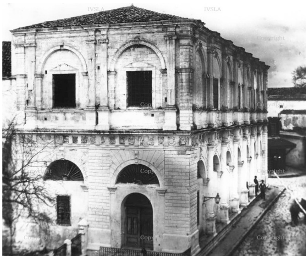
4: G. Gerola, la Loggia vista da nord-ovest prima della demolizione, inizi XX secolo [Gerola 1917, p. 50].
