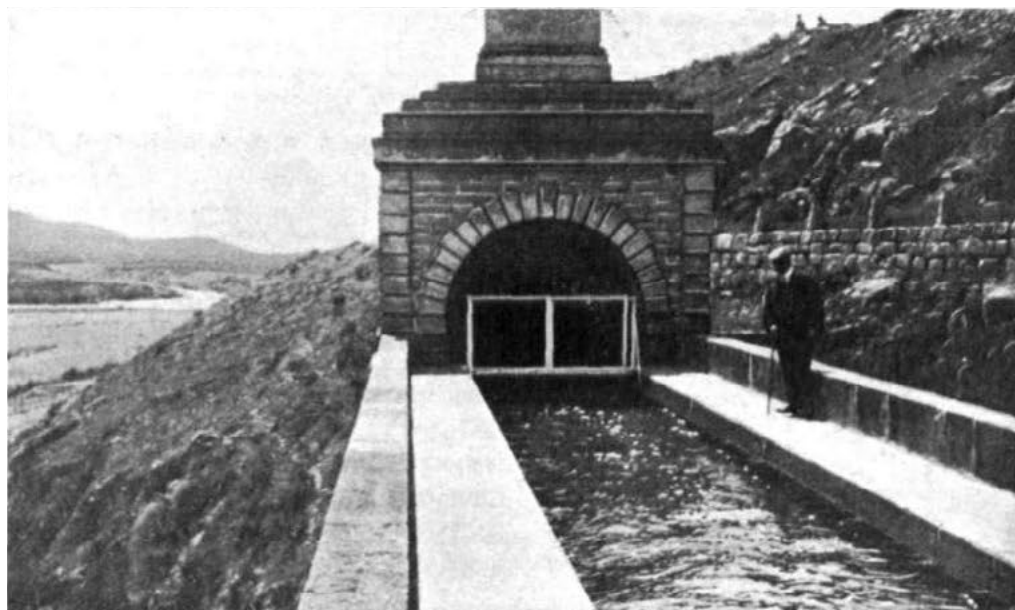
1: fotografia dell'entrata dell'acqua del Pontón de la Oliva nella parte coperta del canale Isabella II ("La Ciudad Lineal", anno XVIII, n. 539, 20 novembre 1913, p. 374).
