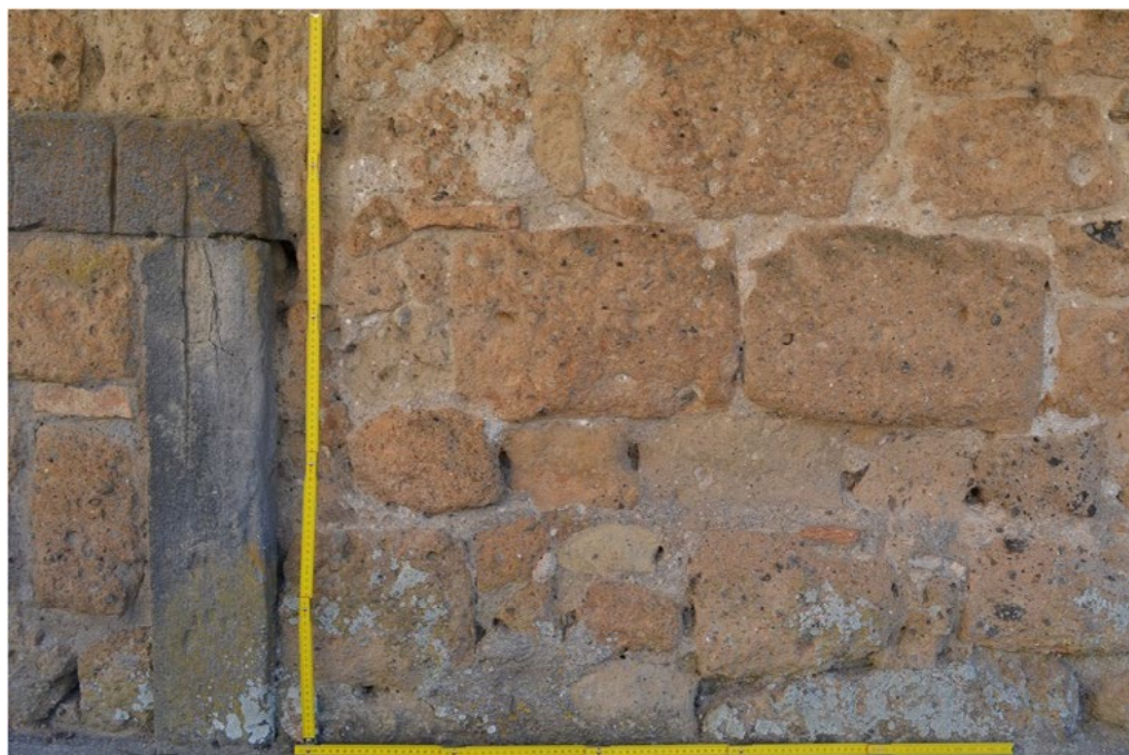
5: Isabella Zamboni, Prospetto esterno nord di Palazzo Arcangeli, 2016. Tecnica costruttiva in elementi di Ignimbrite di Orvieto-Bagnoregio, sbazzati, spaccati e di reimpiego, corsi sub-orizzontali e abbondante malta di allettamento.
