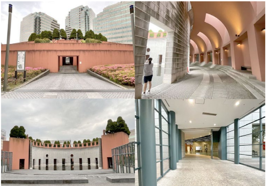
1: Mario Bellini, Yokohama Business Park, Yokohama, 1990 [fotografia dell'autrice del 2022].
