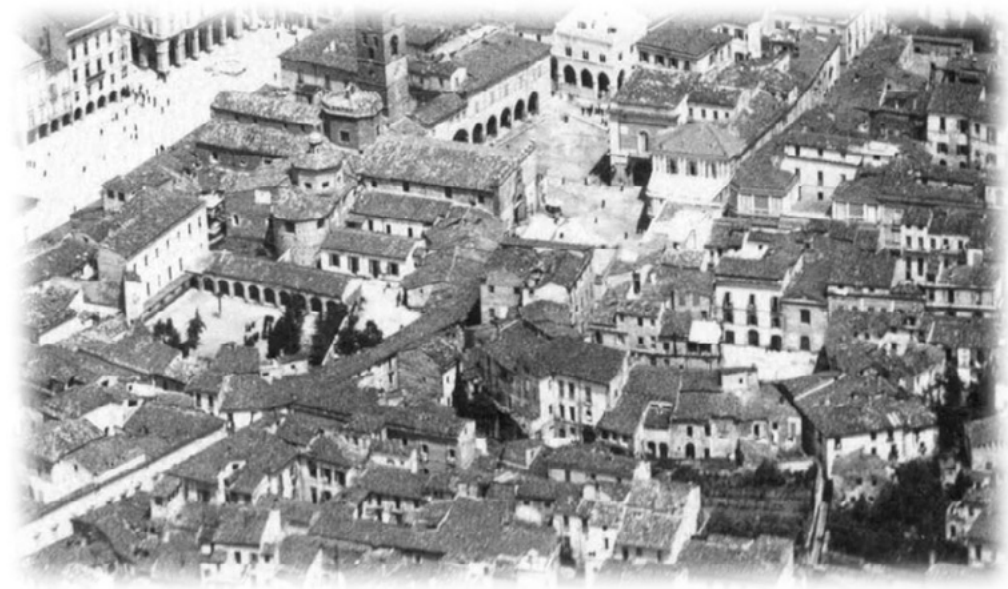
2: foto aerea dell'area prima dei diradamenti, 1927 [Castellucci 2006].
