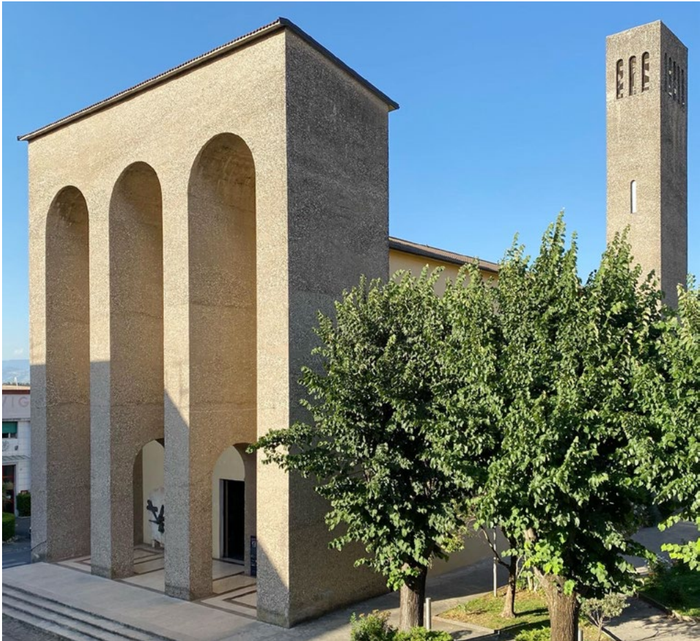
4: Fronte della Chiesa di Santa Barbara a Colleferro. La superficie in pietra artificiale è presente anche sul campanile a destra. Si evidenziano i segni orizzontali dati dalle riprese di getto. Altre forme di degrado sono presenti all'intradosso degli archi, con ferri lisci d'armatura esposti alla corrosione e lungo il basamento, con segni di umidità di risalita. Davide Galleri, luglio 2022.
