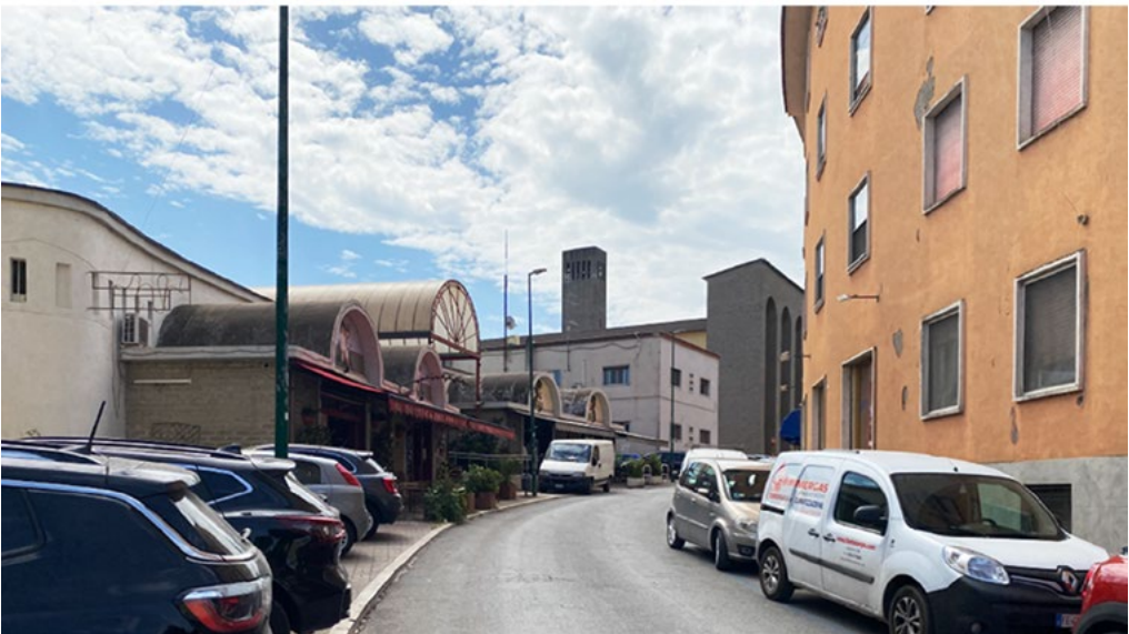
3: Confronto tra le condizioni originarie dell'edificio del Mercato coperto (immagine superiore) e le attuali, con le superfetazioni esterne (immagine inferiore). Immagine superiore ripresa da Archivio Digitale della Città Morandiana, Colleferro. Immagine inferiore Davide Galleri, luglio 2022.
