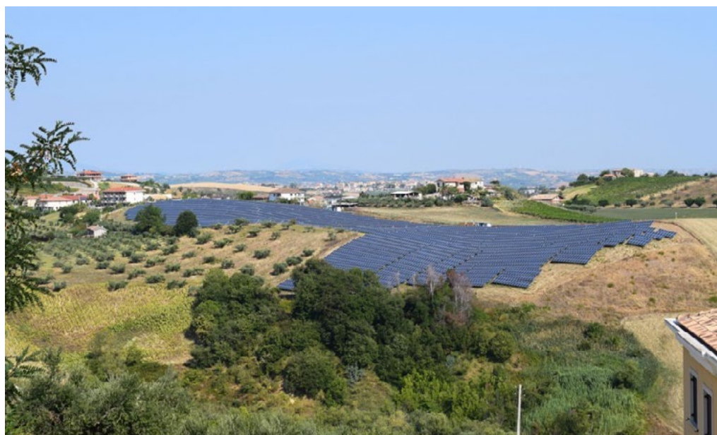
1: Impianto fotovoltaico nel territorio della provincia di Teramo, anno 2017. [Bocca A.]
