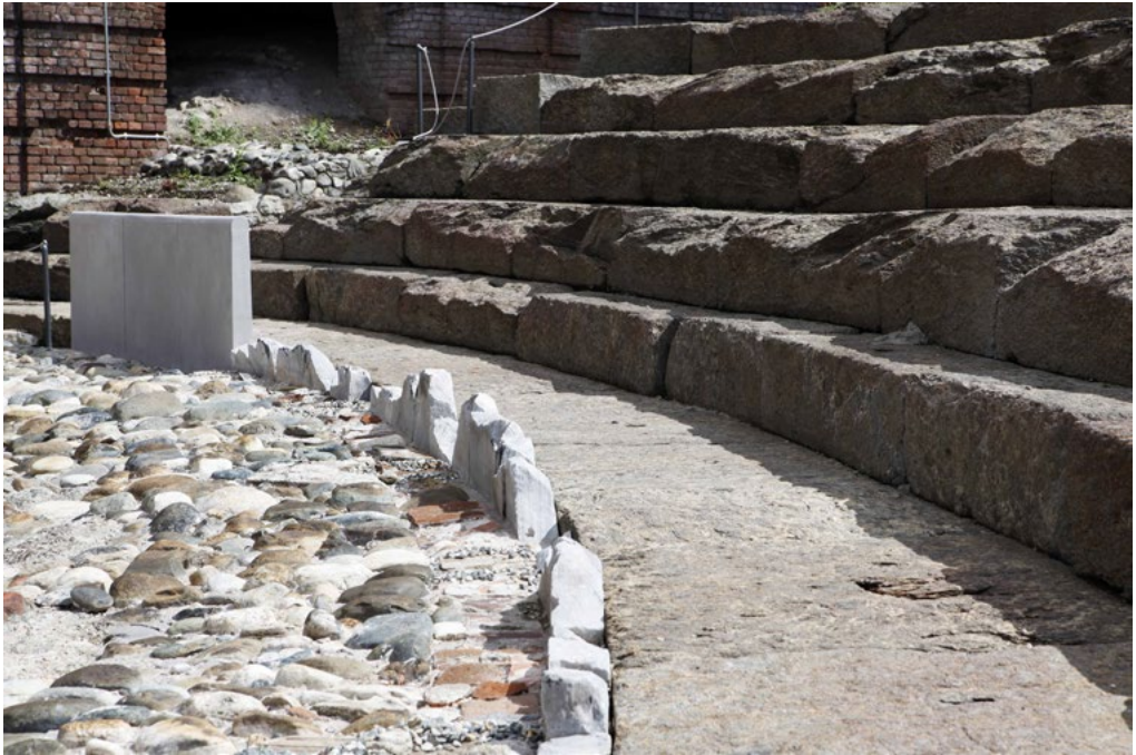
3: La precinzione inferiore della cavea. In primo piano a sinistra, il vespaio di fondazione della proedria dopo il consolidamento, che consente la lettura delle fasce terrazzate. Al fondo a sinistra è visibile l'integrazione didattica di tre lastre del balteus marmoreo, di cui in sito si conservano alcuni frammenti [Foto: Musei Reali, 2021].
