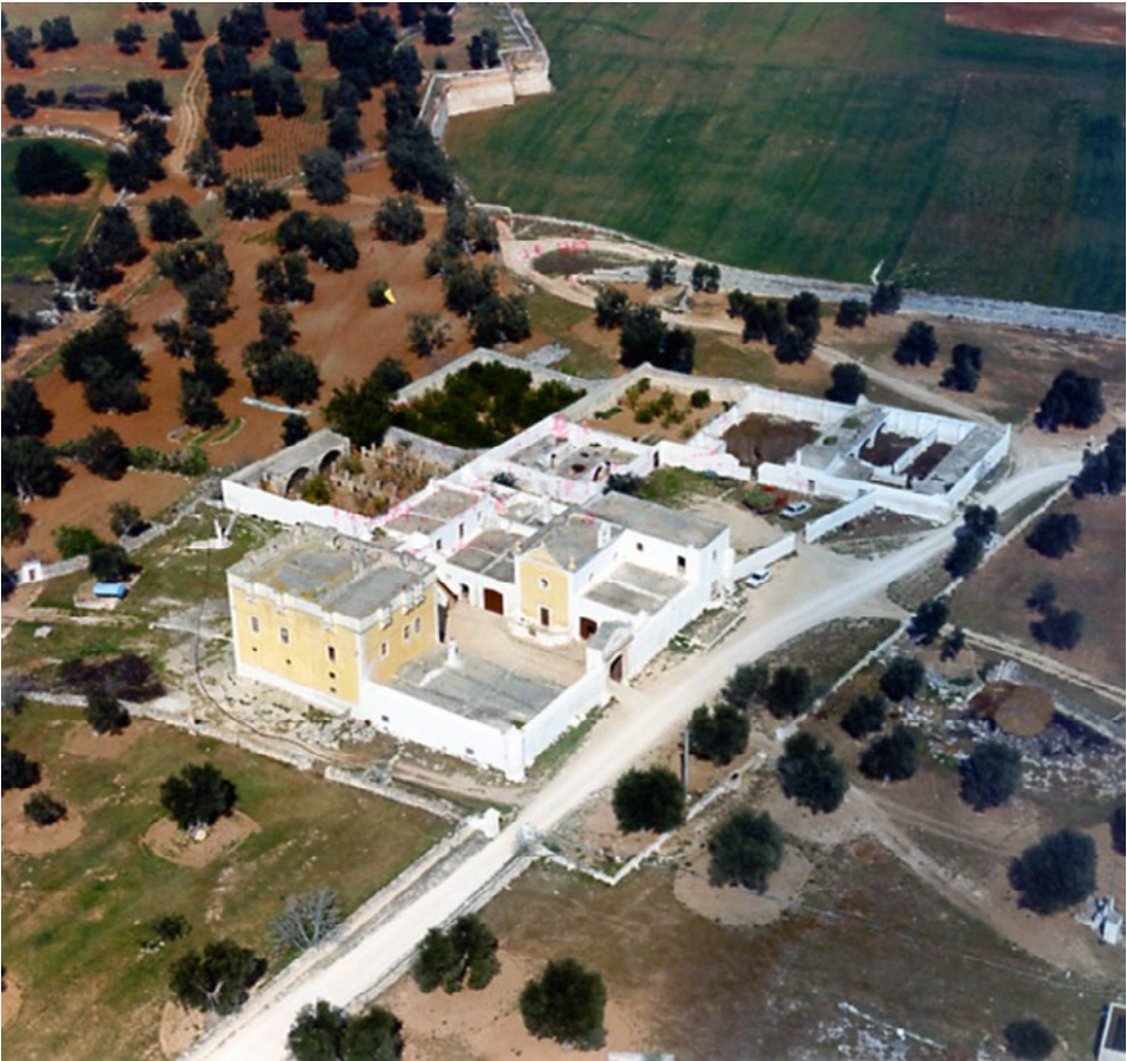
4. Fasano, veduta aerea della masseria borgo San Marco.
