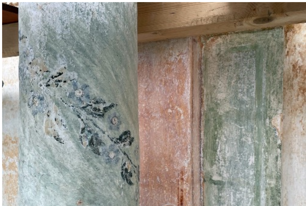
5: Nardò, Chiesa dell'Immacolata, Masseria Brusca, sec. XVIII. Particolare della colonna e degli sfondati nella fase di pulitura (foto durante i restauri - 2022).
