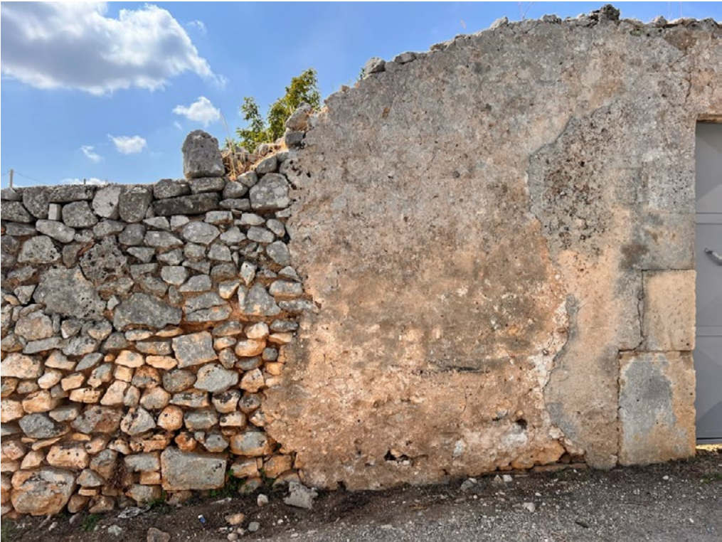
3: La cazzafitta. Un esempio di malta di terra a base di calce aerea.
