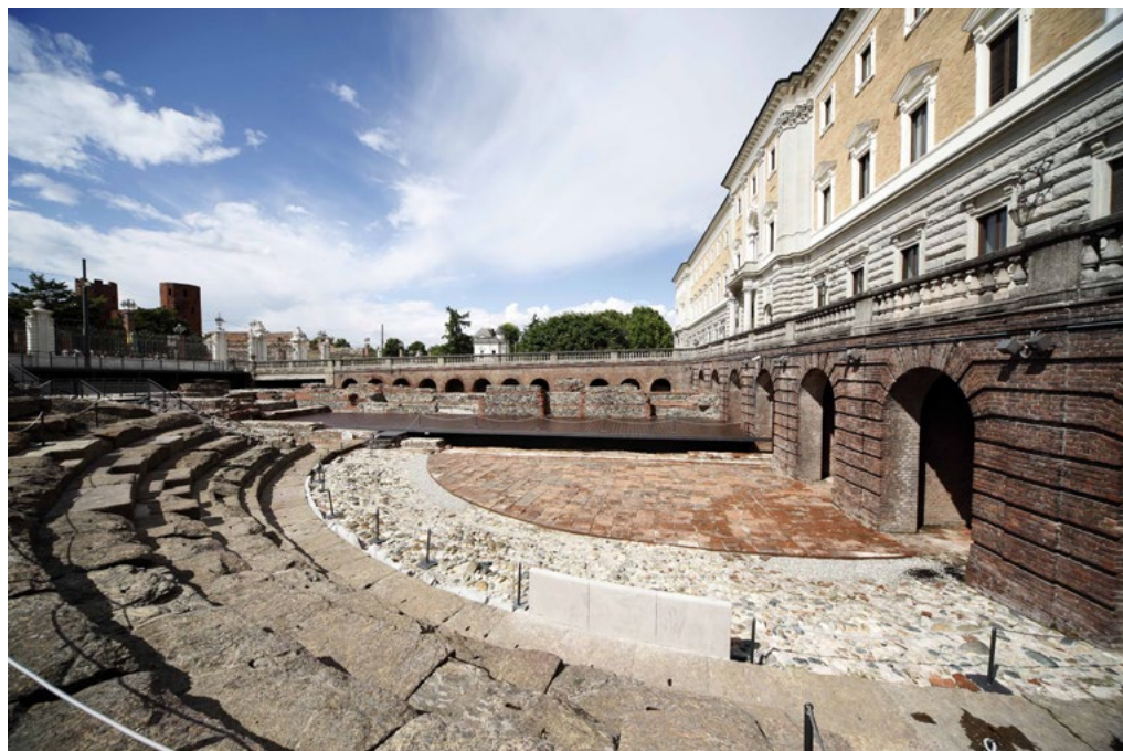
1: Il Teatro al termine degli interventi di restauro [Foto: Musei Reali, 2021].
