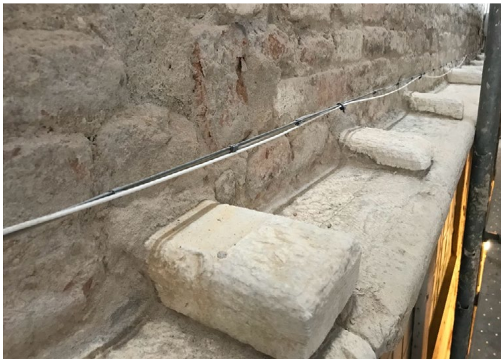
4: Listolina in pietra a protezione del sottostante architrave in legno in un tipico edificio con configurazione a ritzi al piano terra. Sestiere San Marco, foto dell'autore, 2021.
