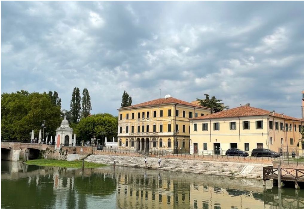
2: Foto dell'autore. La scalinata monumentale del Piovego oggi, a seguito dei lavori di recupero e restauro.
