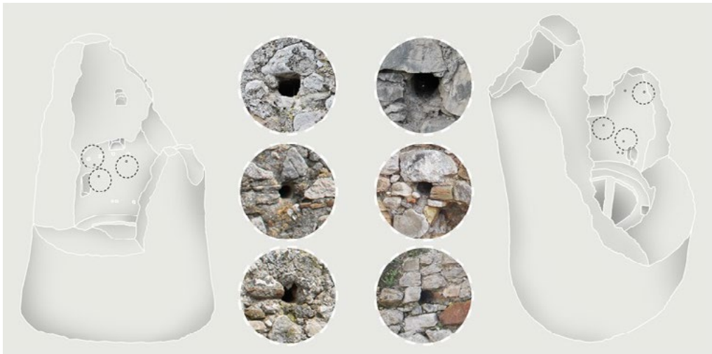
5: Cerreto antica (Cerreto Sannita, Benevento). Schema con indicazione della posizione di alcuni dei rinforzi lignei disposti trasversalmente alla muratura (Giacco, Iovine 2021).
