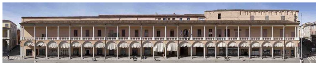
5: Faenza, Palazzo Comunale, facciata (fotografia di Lucio Rossi).
