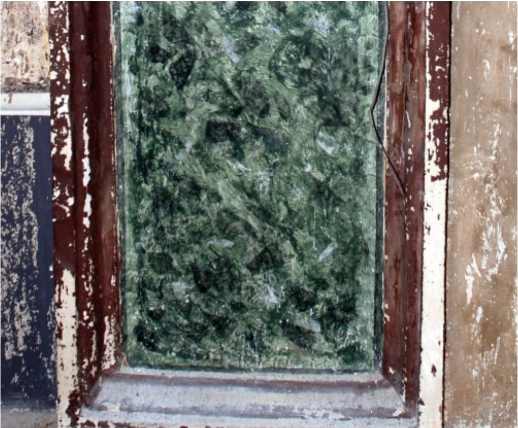
4: Nardò, Chiesa di S. Antonio di Padova, sec. XVIII. Particolare della parasta a sinistra dell'altare maggiore durante le fasi di indagini delle stratigrafie cromatiche e rinvenimento del finto marmorino sottostante (foto prima dei restauri - 2004).
