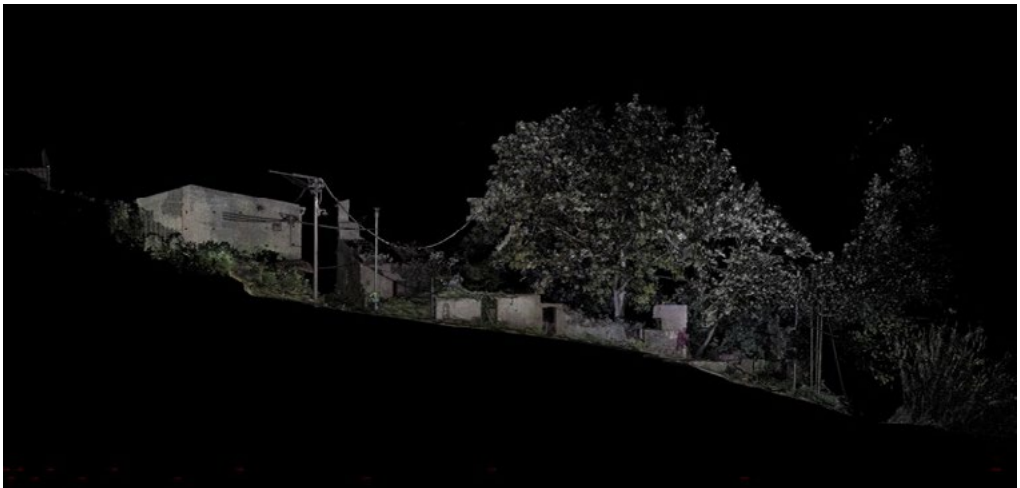
4: Nuvola di punti da laser scanner della sezione del centro lungo una delle strade del centro che raggiungono il torrente Corsari.
