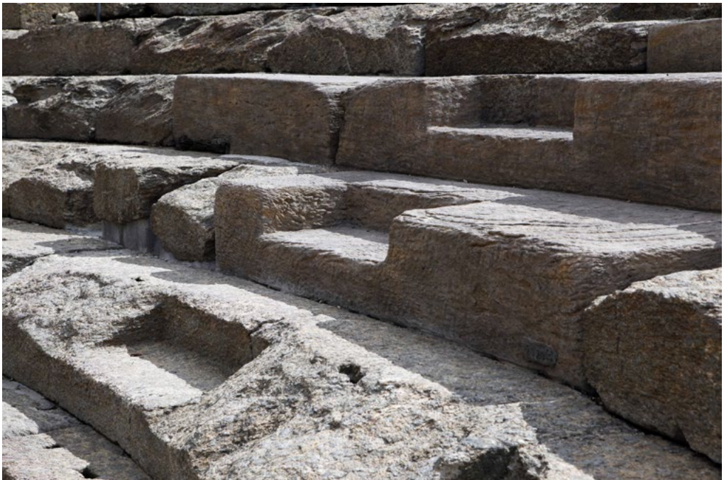
4: La scaletta di risalita del meniano inferiore, con le integrazioni in pietra artificiale [Foto: Musei Reali, 2021].
