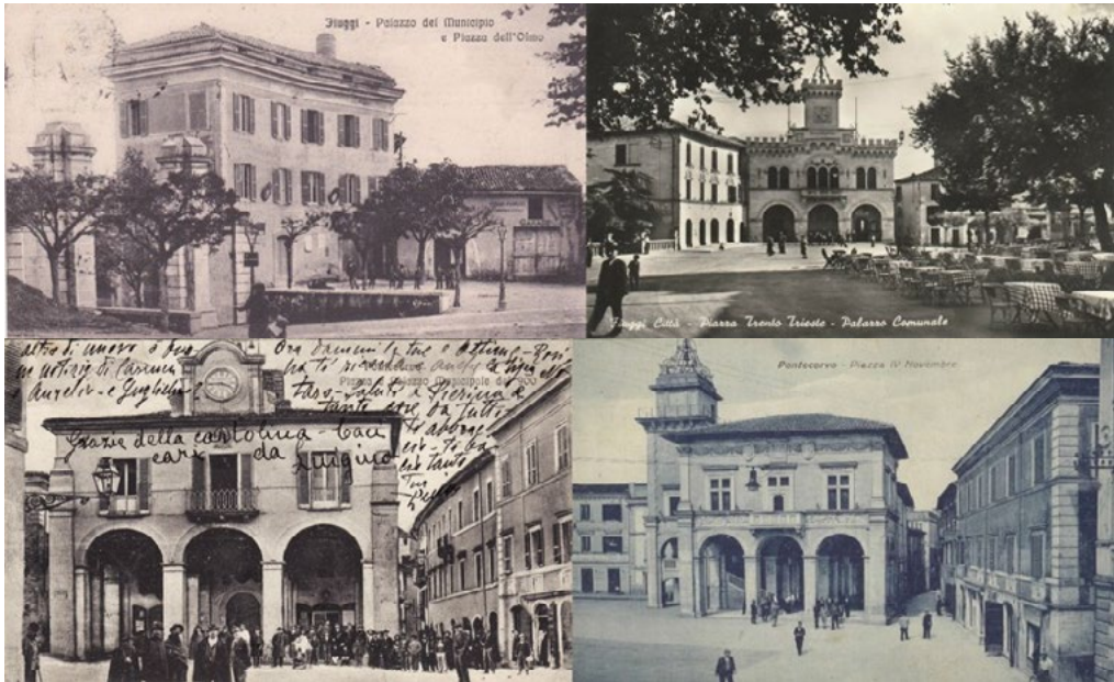
1: A. In alto: Fiuggi (FR), il palazzo del Municipio in due cartoline del 1914 e 1960 che mostrano l'aggiornamento della facciata e l'aggiunta del nuovo volume turrato in stile neo-cinquecentesco. B. In basso: Pontecorvo (FR), il palazzo del Municipio in due cartoline della prima metà del Novecento che mostrano l'aggiornamento della facciata e l'aggiunta della torre dell'orologio
