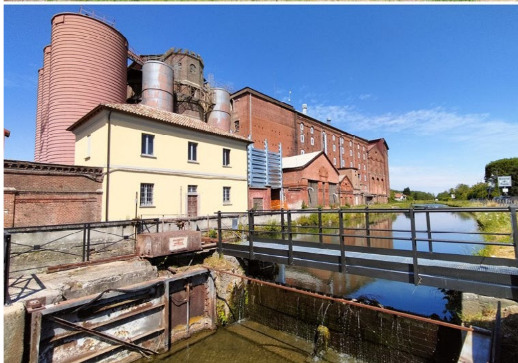
2: In alto, vista dell'edificato di Borgo Calvenzano nel tratto del Naviglio Pavese in cui è presente il salto di Conca Cairoli; in basso, vista dei Molini Certosa, tutt'ora in attività. L'edificio si sviluppa in prossimità della Conca Certosa, di cui si avvantaggiava la produzione ottocentesca. Foto dell'autore, luglio 2022.
