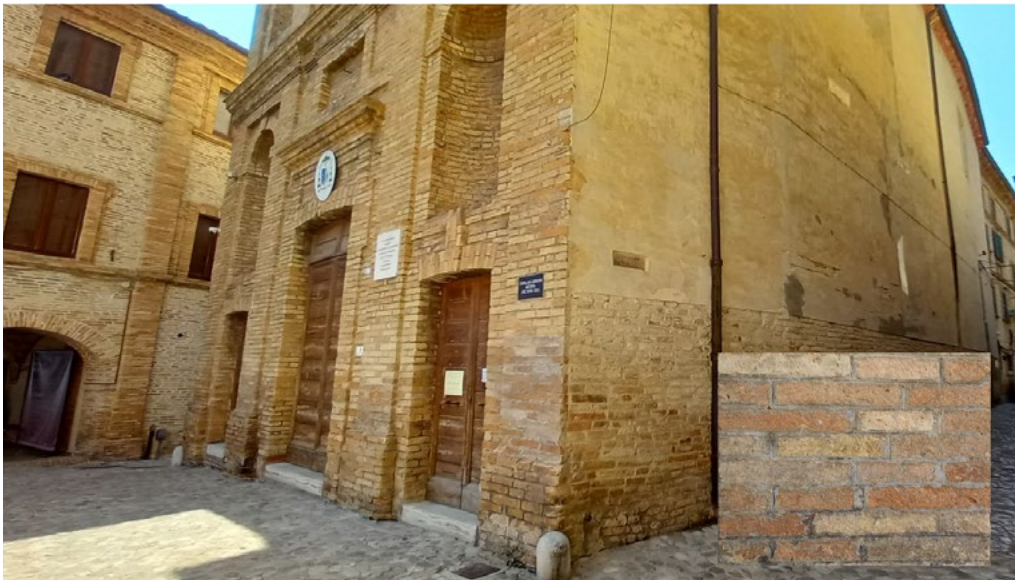
4: La facciata della chiesa di S. Giovanni Battista a Grottammare, commissionata a Pietro Maggi dal vescovo di Ripatransone, terminata nel 1802. Nel particolare della muratura di facciata, in basso a destra, si nota una particolare lavorazione (sagramatura) del mattone [foto dell'autore].
