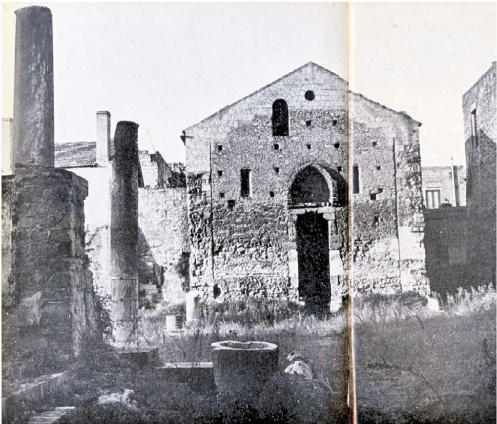
5. Veduta della fronte della Basilica di S. Giovanni da foto pubblicata nel 1965.
