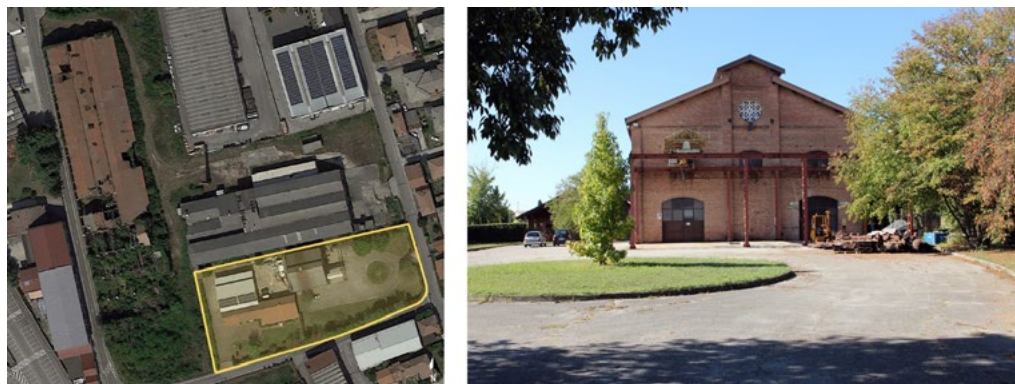
1: Stato di fatto dell'area di studio dello stabilimento dismesso Boranga a Montebelluna: vista aerea con evidenziato il perimetro dell'area; vista dell'edificio preesistente vincolato.
