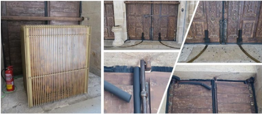
2: Portico della Gloria: a sinistra una delle due UTA presenti, a destra il Portale dell'Obradoiro.
