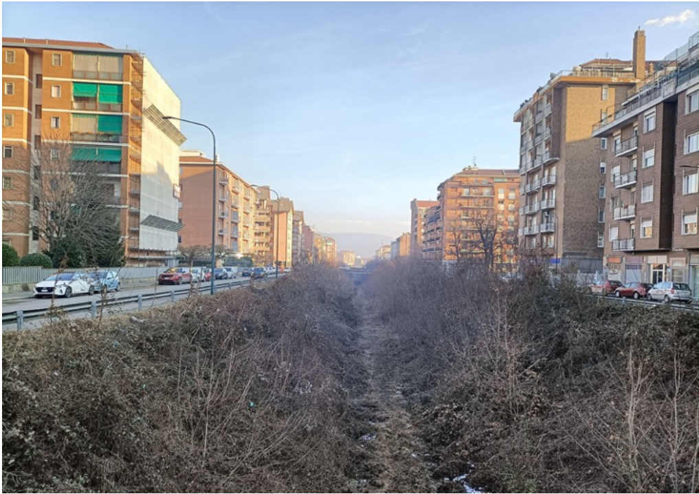
3: Oddi R. F., Veduta della trincea ferroviaria dismessa tra via Gottardo e via Sempione, Torino, 2022 [Fonte: foto Roberta Francesca Oddi 27/01/2022].
