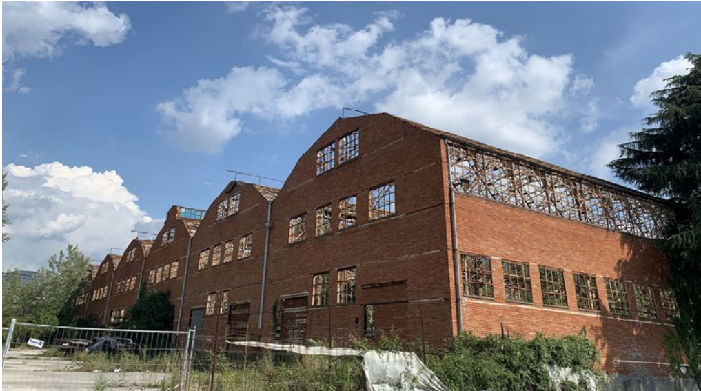
4: Veduta del capannone spedizioni. (fonte: foto dell'autrice, agosto 2022).
