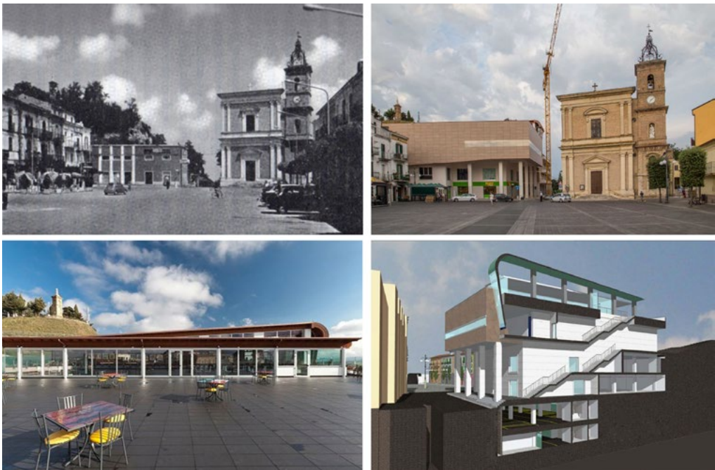
5: Due immagini di piazza Garibaldi, nel centro di Atesa, che individuano chiaramente l'alterazione del contesto dovuta alla sostituzione del Cinema Italia con l'edificio polifunzionale. Il rapporto con il costruito urbano e la morfologia del terreno retrostante viene modificata con l'inserimento di una megastruttura geometricamente e materialmente diversa. Progetto architettonico: C. Ferrara, T. Fabrizio, P. Iadisernia, M. Lancini.
