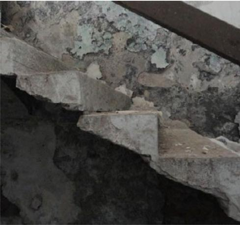
**5:** Materiali e peculiarità costruttive: un raro esempio di scala con gradini a sbalzo della lunghezza di circa 150 centimetri in arenaria.
