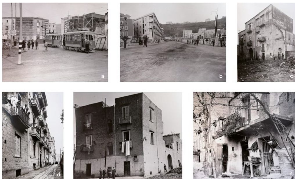
4: Risanamento di Fuorigrotta, foto di Aucone Giovanni: (a) la nuova strada avanti la chiesa rionale, s.d.; (b) rione Campi Flegrei, via Caio Duilio, s.d.; (c) via del Fosso n. 13, 03/11/1939; (d) via del Fosso, fabbricato n. 25, 02/06/1939; (e) via Ignarro dal n.1 al n. 7, 07/11/1939; (f) via Giacomo Leopardi, cortile, 17/04/1940. [ASMUN, FF, OO.PP, RdF, Strade: cod. 00341; cod. 00458; cod. 00463; cod. 00464; cod. 00466; cod. 00485].
