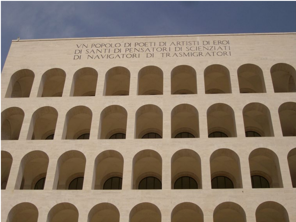
2: Dettaglio del cornicione della facciata principale di Palazzo della Civiltà Italiana [Fotografia dell'autrice].
