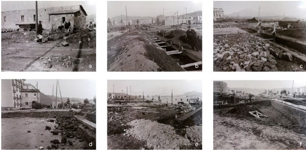
6: Risanamento di Fuorigrotta, foto di Aucone Giovanni: (a-b) lavori in corso, 28/01/1940, [ASMUN, FF, OO.PP, RdF, Lavori in corso: cod. 00607; cod. 00608]; (c-f) lavori in corso, 09/02/1940, [ASMUN, FF, OO.PP, RdF, Lavori in corso: cod. 00609; cod. 00610; cod. 00611; cos. 00612].
